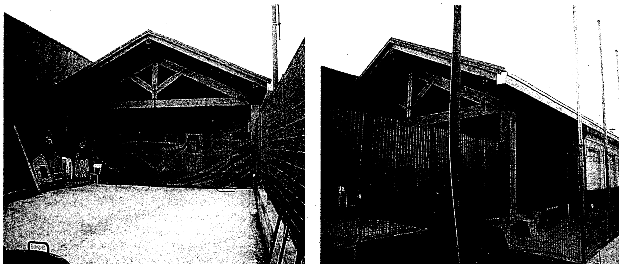
Nelle foto, il cortile interno e una veduta dall'esterno della nuova ala della scuola materna parrocchiale
