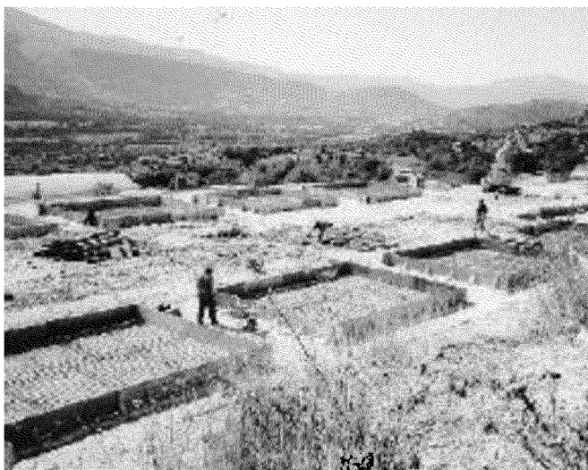
Un'immagine del cantiere post-terremoto: ieri la consegna delle case
