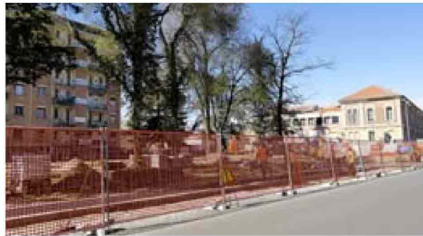
I LAVORI IN CORSO LUNGO VIA DELLE ROSETTE
