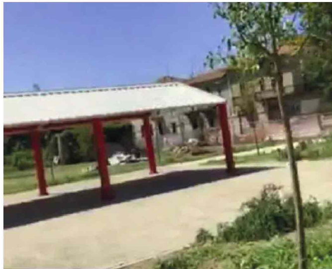
UNA PIAZZA VERDE Proseguono i lavori nell'area che sarà inaugurata il 20 settembre prossimo
